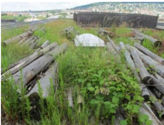
Abbildung 6: Beispiel einer Dachbegrünung mit zusätzlichen Biodiversitätsbausteinen
